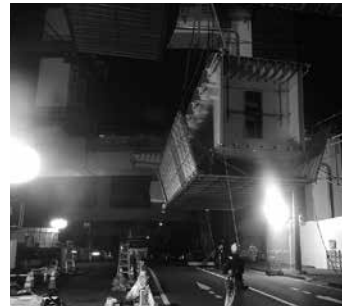
▲Ⅲ-1工区の鋼床版箱桁単材架設(夜間工事)
