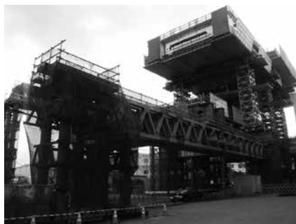
▲Ⅲ-1工区の大型特殊ベント設置
