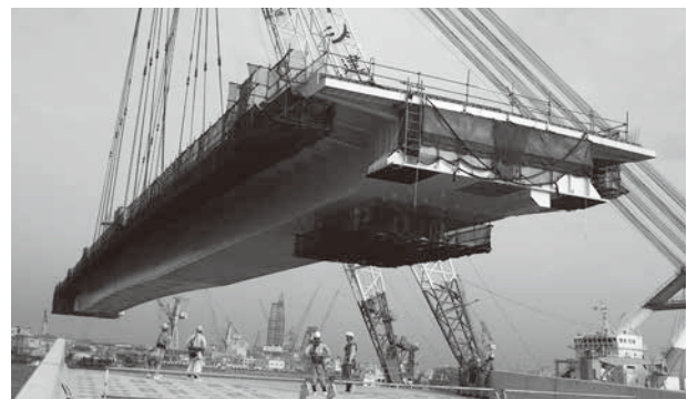
▲Ⅵ区の鋼床版箱桁大ブロック架設
