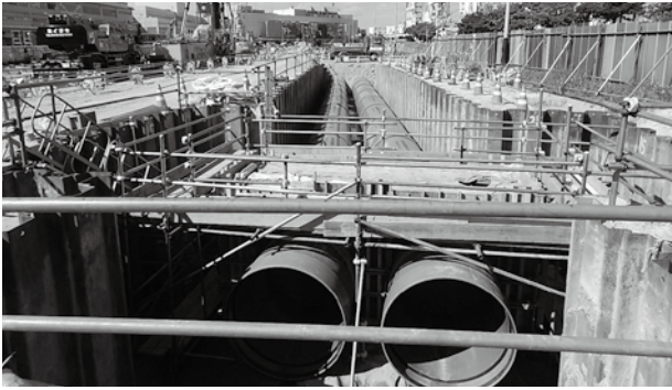
▲排水管 (FRPM管 φ2,000mm×2本) の設置状況
