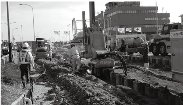
▲鋼矢板(土留矢板)打設状況
