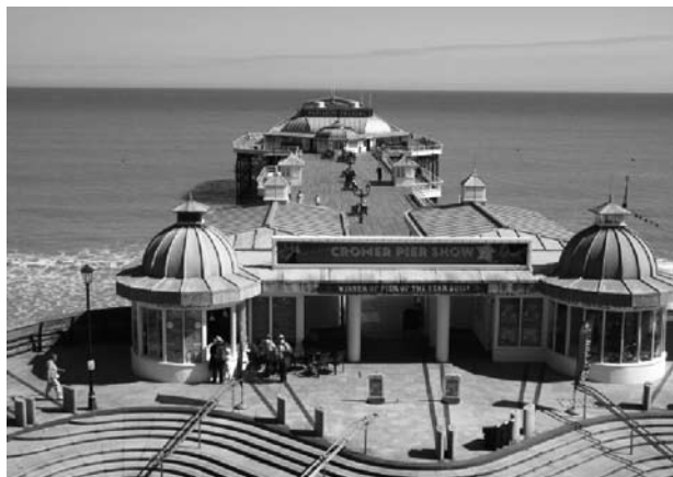
市街地から望むクローマー栈橋
