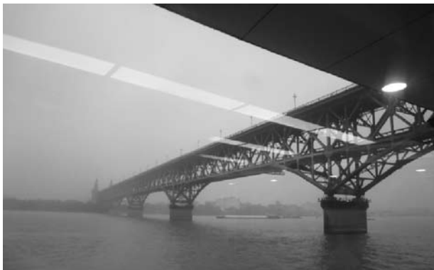
1968年完成の長江大橋
