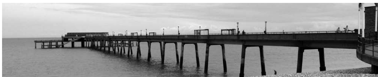
ディール栈橋全景
