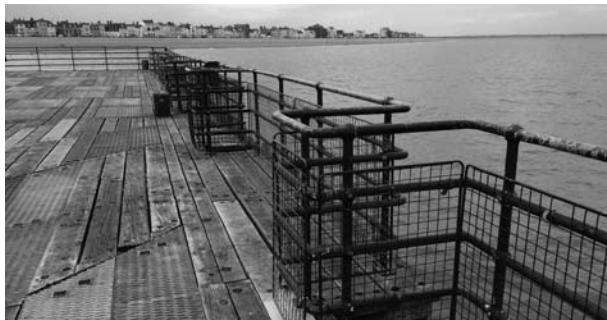
上：栈橋先端の下部デッキ/下：栈橋先端の上部デッキ
