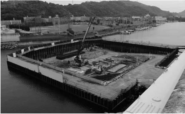
基礎杭打設が完了している水門整備の現場では、仮締め切りした後、地下水位を下げるために水抜き試験（ウェルポイント）が行われていました。一度水位を下げ、中の状態をドライにして陸上作業と同じように施工ができるようにするのです。取材時は水面下2mでしたが、ここからさらに約4m掘り下げ、全体で6mまで掘り下げます。「周囲が海面なので、海水がにじみ出ると施工ができなくなります。どのような方法にすれば安全に施工ができるかを検討しながら進めています」（調査役 島崎さん）
