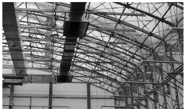
▲投入台船内部、集塵システムとミストシステム
