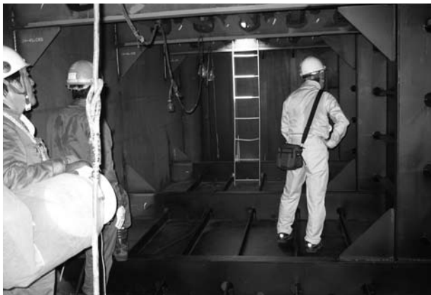
▲投入台船の溶接確認状況
