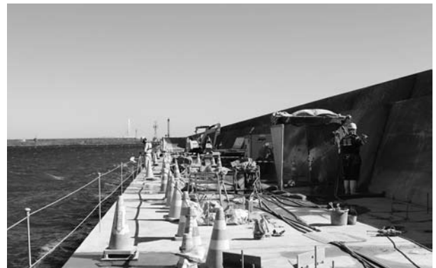
▲鍋田堤の現場の様子
