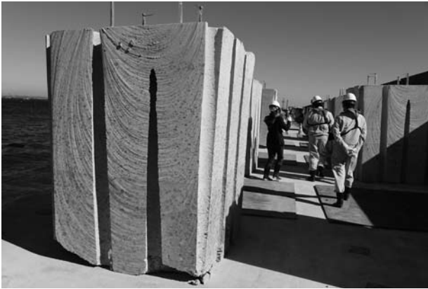
▲切断され、くり抜かれた上部コンクリート
