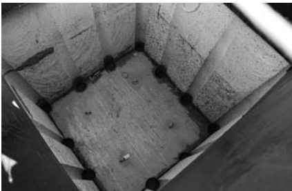
▲切断され、くり抜かれた上部コンクリート
