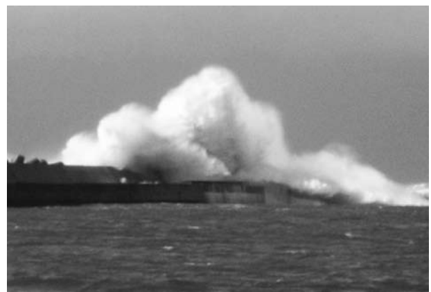
▲防波堤の越波状況
