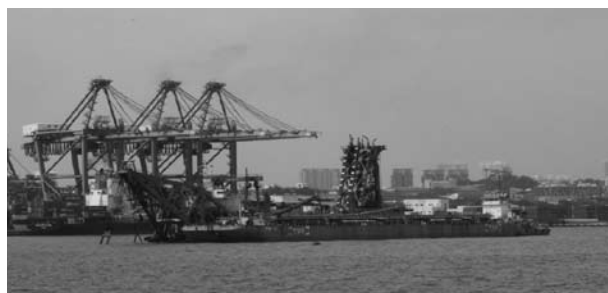
▲浚渫船による作業の様子
