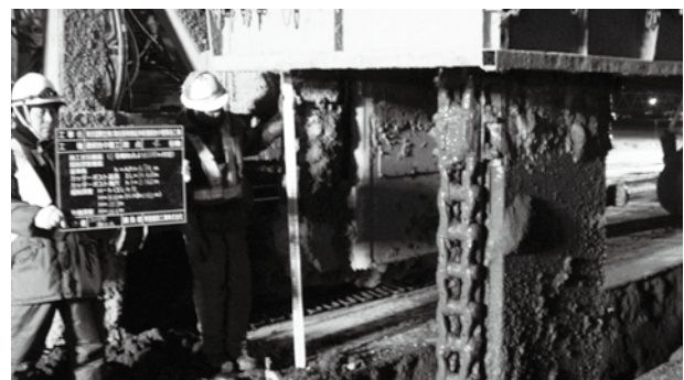
▲連続地中壁TRD機の掘削深度の確認状況
