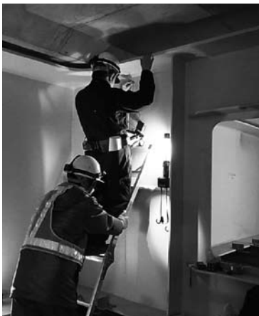
▲ジャケット内部の調査状況
