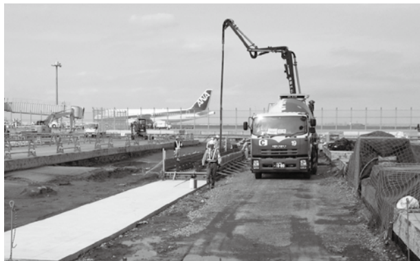
▲表面排水工のコンクリート打設状況
