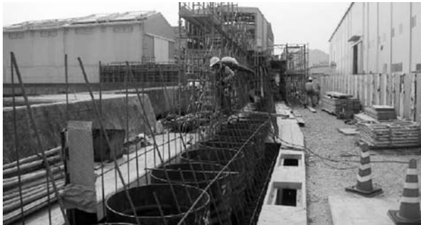
観音地区 鉄筋組み立て（上部工）
