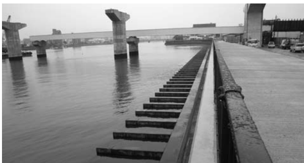
吉島工区堤防
