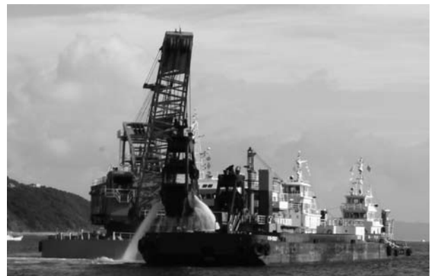
▲浚渫作業の様子
