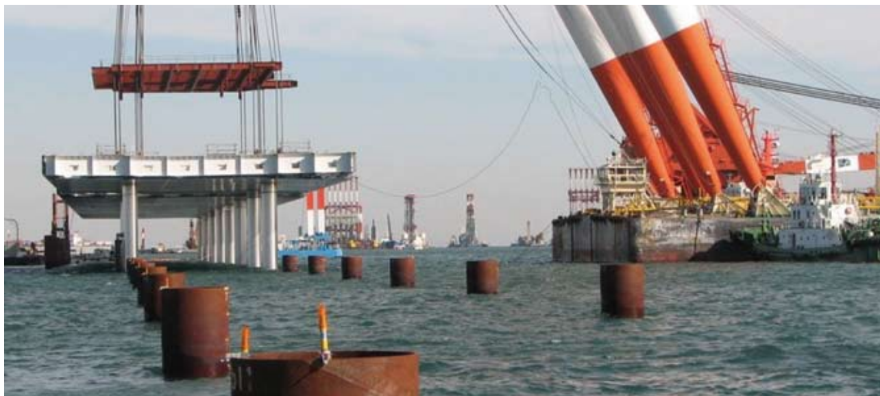
据付現場（左側の白い部分がジャケット）
