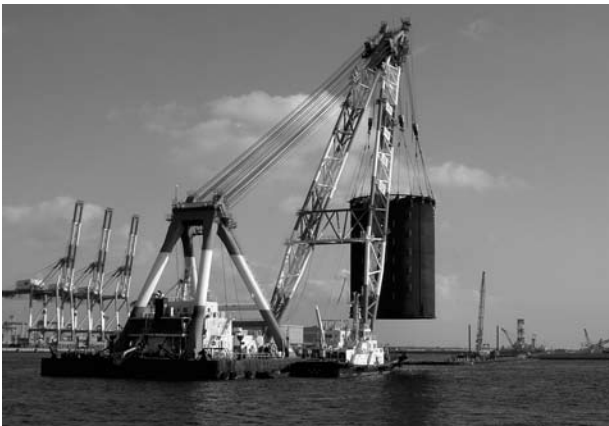
▲鋼板セルの据付け
