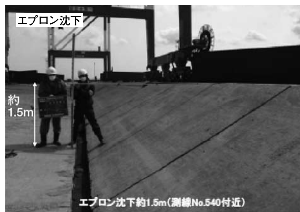
▲ (常陸那珂港区) 北小頭地区岸壁-14m
