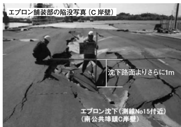
▲（鹿島港）南公共ふ頭地区岸壁-7.5m
