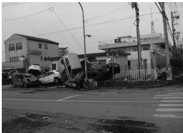
▲津波に巻き込まれた塩釜港湾事務所
