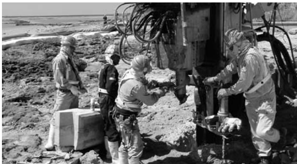
▲先行ビット取付け作業
