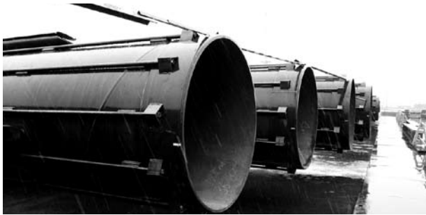
▲地中の岩盤に打設する鋼管
