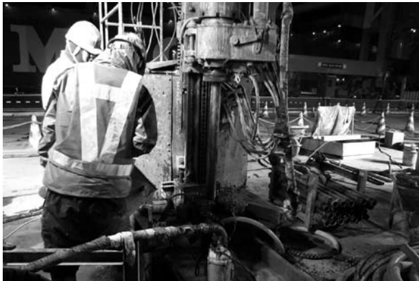
▲夜間工事の様子
