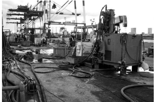
▲CPG工法による液状化対策工事
