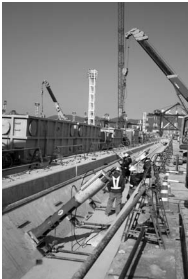
▲グラウンドアンカー工法による耐震補強工事
