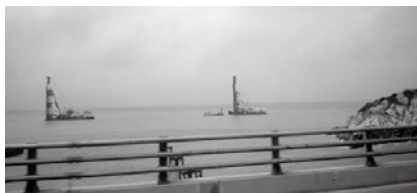
▲拡張地域での地盤改良
