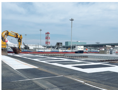
フェンスを隔ててすぐに供用中の貨物地区のエプロンがある
