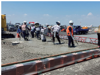
ピット付近のコンクリート打設状況 (2025 年 7 月)
