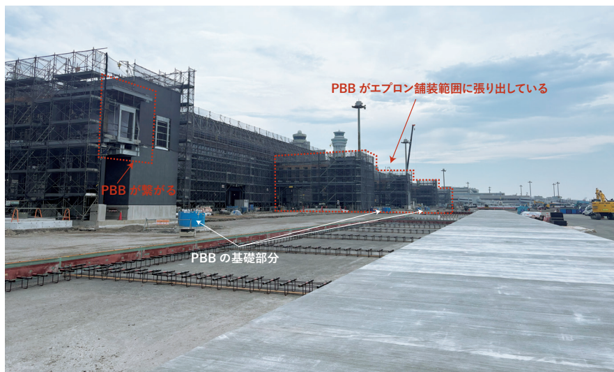
北側サテライト施設の現場と近接しているエプロン舗装工事現場 エプロン舗装工事とサテライト建設工事の施工範囲が重なる部分があるため、綿密な工事スケジュールの調整が必要となる
