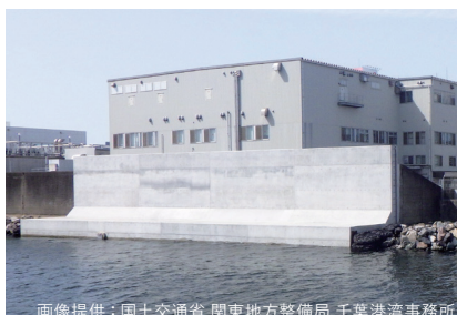
画像提供：国土交通省 関東地方整備局 千葉港湾事務所 工事完了状況(日の出護岸)(上のDATA図 C地点) 幅員約3.4mの道路から、夜間にコンクリートの打設が行われる
