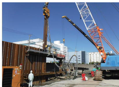
高剛性壁体の打設状況
