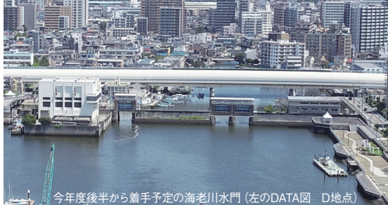
今年度後半から着手予定の海老川水門(左のDATA図 D地点)
