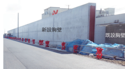
工事完了状況（日の出胸壁/海側） （右上のDATA図 B地点）
