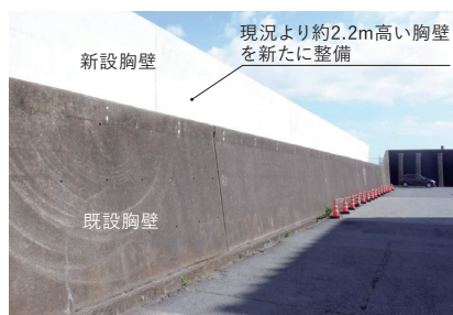
工事完了状況（日の出胸壁/陸側） （右上のDATA図 A地点）
