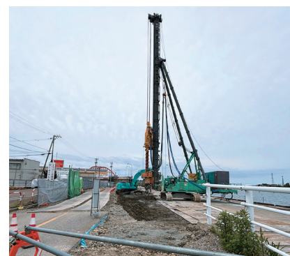
地盤改良工事施工状況
