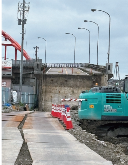
A2橋台付近の撤去状況
