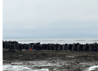
越波対策のために設置された大型土のうと、海上に設置された汚濁防止膜(左の図A地点から撮影)
