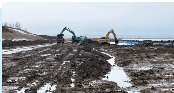
裏埋土掘削・運搬状況。土砂の下には、ケーソンとその土台となる捨石が埋まっており、ケーソン破砕後、撤去していく（右上の図A地点から撮影）
