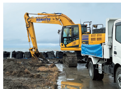
舗装版を削りトラックへ積み込み、仮置き場へ運搬する
