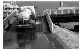
▲散水車は頻繁に使用して工事用道路を洗浄
