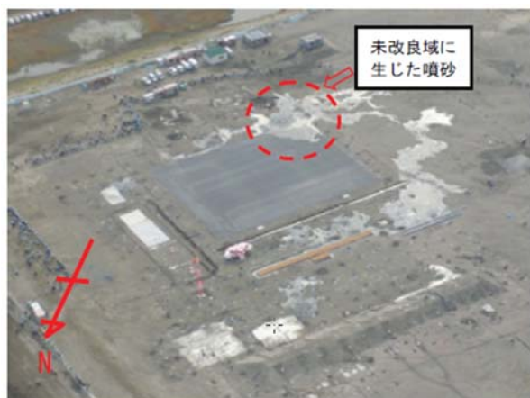
実大規模液状化実験
