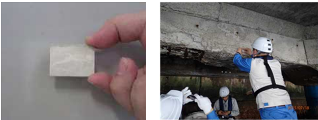
写真-1 モルタル板の外観と設置作業状況
