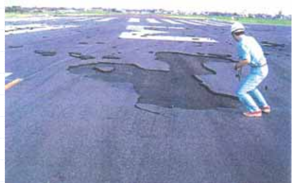
滑走路の損傷事故 コアの状況
