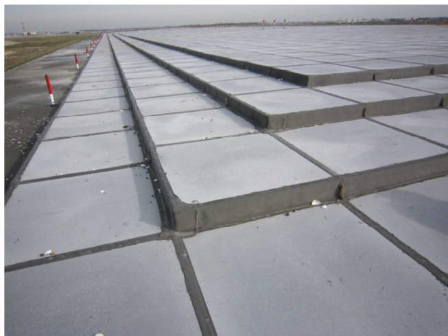
写真-1 4R 滑走路端 EMAS の状況(外観)
