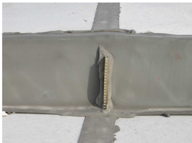
写真-2 4R 滑走路端 EMAS の状況(水抜きパイプ)
