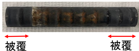
図-3.11 改善した加工による鉄筋腐食の状況
