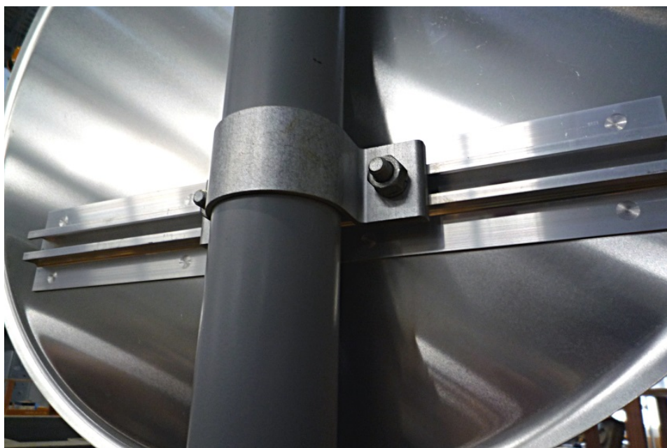
写真－2.3 看板を取り付けた様子
