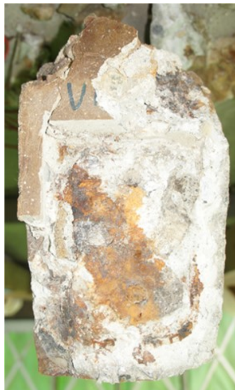
端部状況写真(エポキシモルタル除去後)
