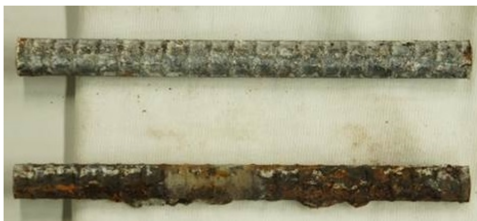
図 4-5 内部主鉄筋の腐食状況(上：載荷写真反対側,下：載荷試験写真側)
