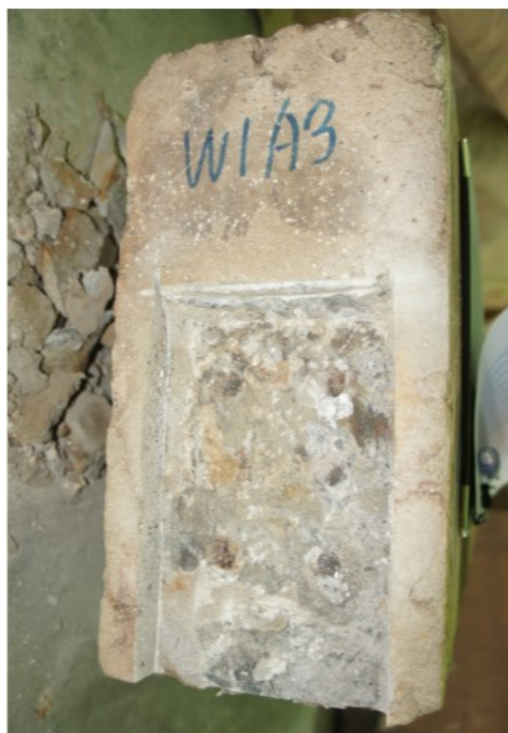
端部状況写真(エポキシモルタル除去後)
