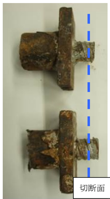
b)内部の腐食(青線位置すぐ右側の断面で EPMA)
