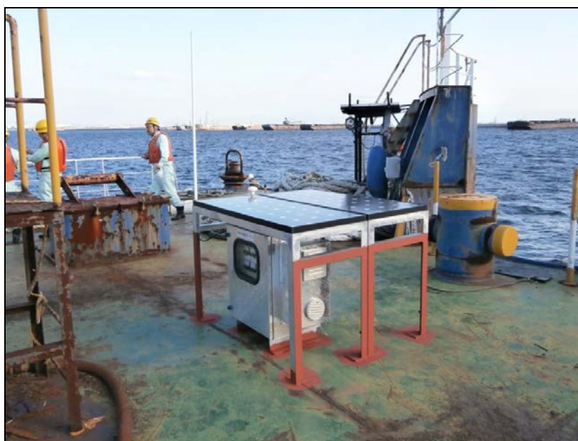
写真-10 実験船（神 B-6005）に設置した自立電源式 AIS 装置（クーラー付き）
