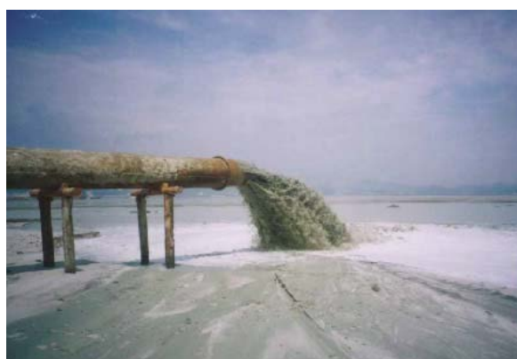
図-1.2 築堤背後に投入される液状～泥状の浚渫土
