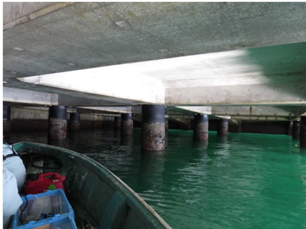
図 4.6 K 県 T 港 棧橋下側の様子
