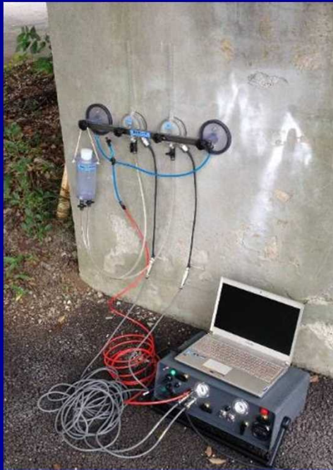
吸水カップの固定・測定時全景
