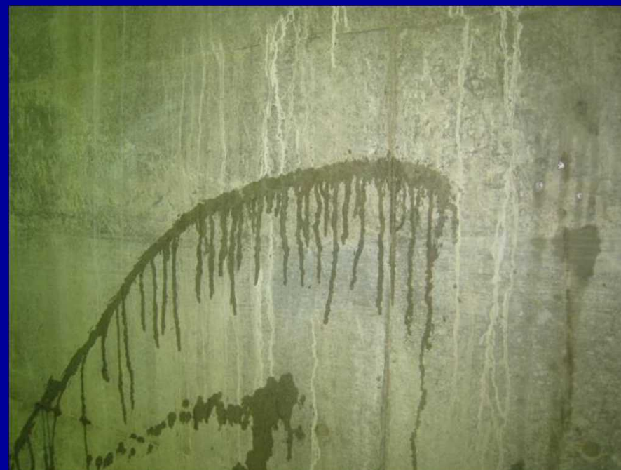
密なコンクリート 水を吸いにくく、表面を流れる
