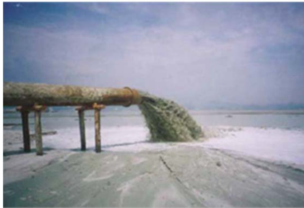
図-1.3 築堤背後に投入される液状～泥状の浚渫土
