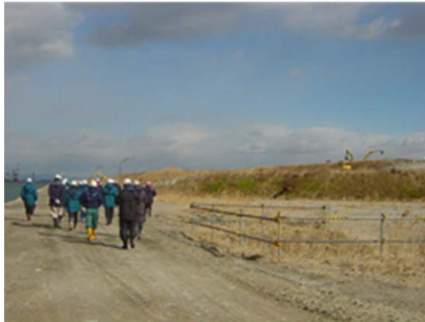
図-1.2 名古屋PIでの築堤の状況
