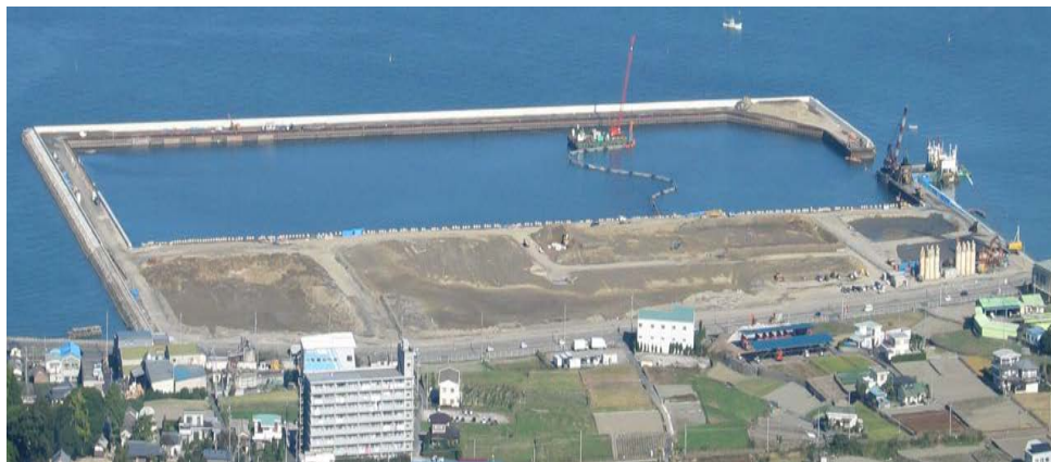
図 2.5 寒川東部臨海土地造成事業における底部遮水構造の施工状況
