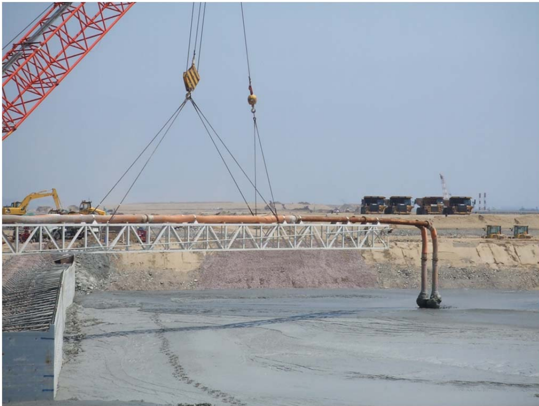
写真-1 羽田空港D滑走路建設におけるSGMの打設状況
