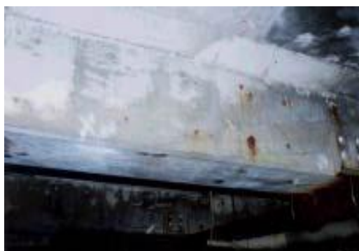
写真-1.1 建設後 20 年以上経過した栈橋上部工の塩害劣化事例 1)
