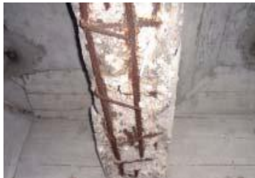
写真-1.1 建設後 20 年以上経過した栈橋上部工の塩害劣化事例 1)
