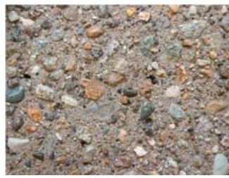
凝結遅延剤+高圧水
