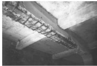
図 2.4 上部工床版下面（左）と梁下面（右）の劣化状況 3)
