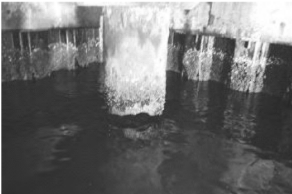
図 2.5 下部工鋼管杭の劣化状況 3)
