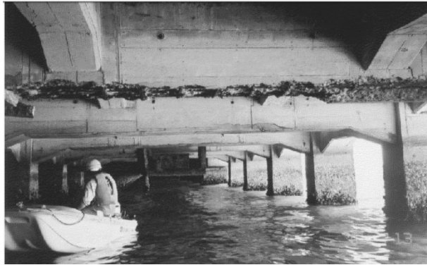
図 2.3 栈橋上部工下面の調査状況 3)
