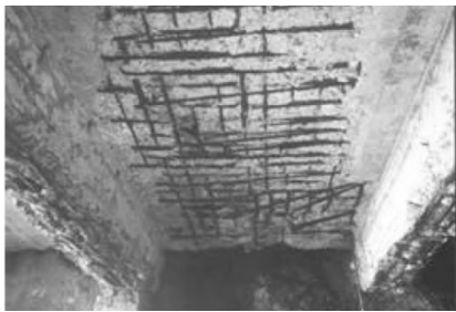
図 2.4 上部工床版下面（左）と梁下面（右）の劣化状況 3)
