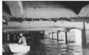
棧橋上部工下面の調査状況
