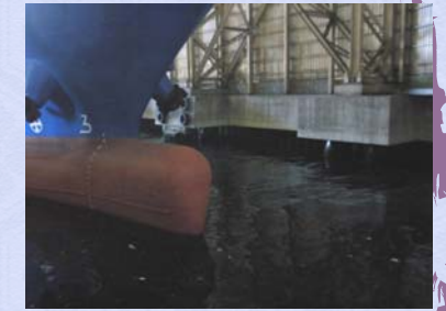
出荷護岸内部 (Dock)
