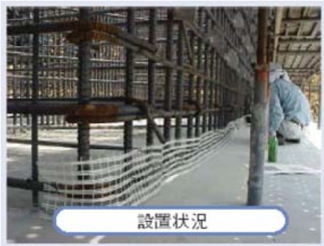
図－１ 繊維シートの設置状況
