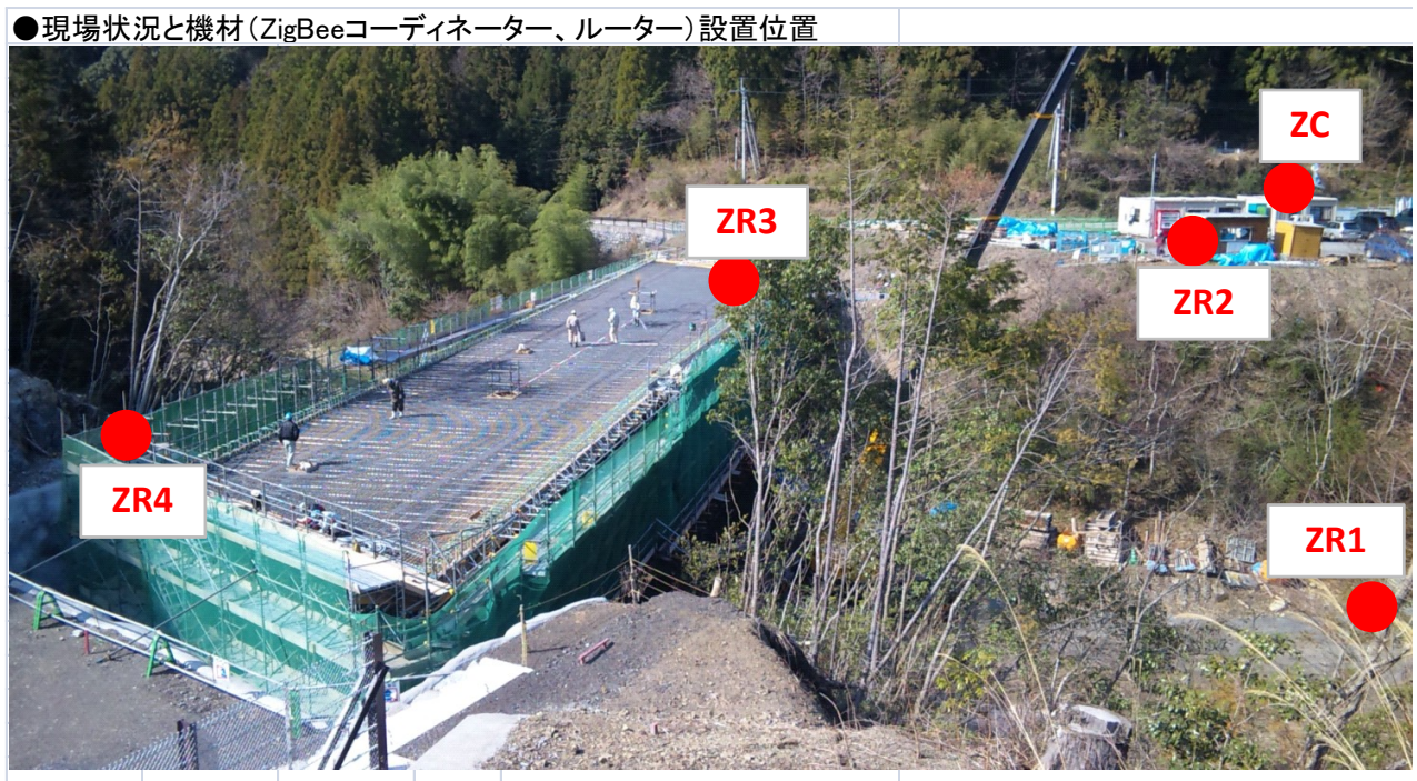
図-3. 20 現場全景と ZC（コーディネータ）および ZR（ルーター）設置位置
