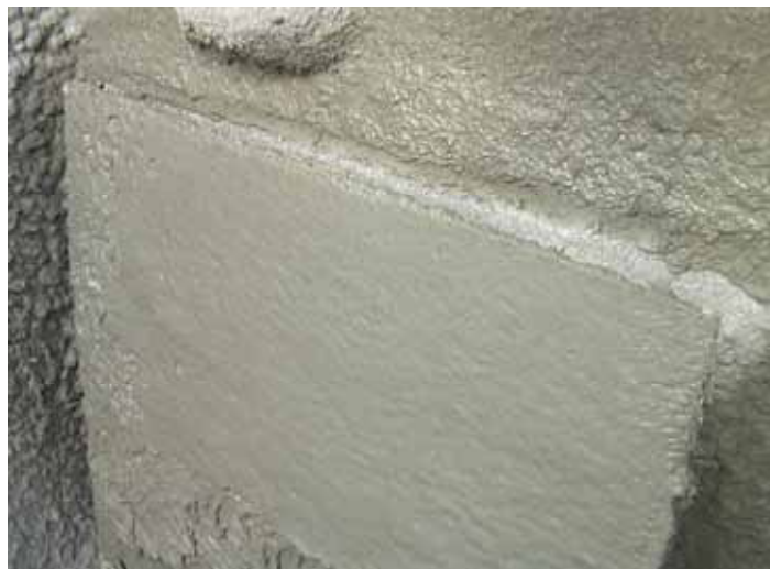
図 - 4.4 仕上げ後の状況
