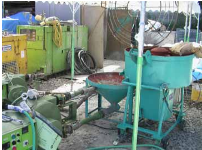
図 - 4.1 吹付けの設備（ミキサ，ポンプなど）
