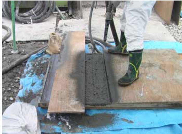
図 - 4.3 吹付け状況
