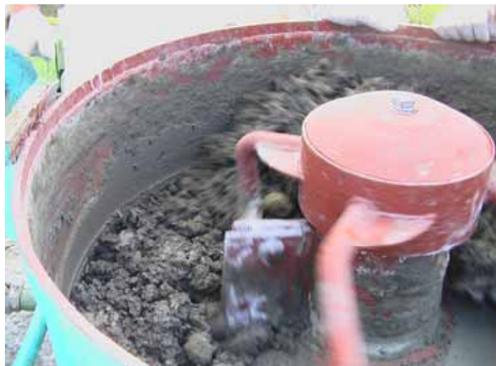
図 - 4.2 練混ぜ状況
