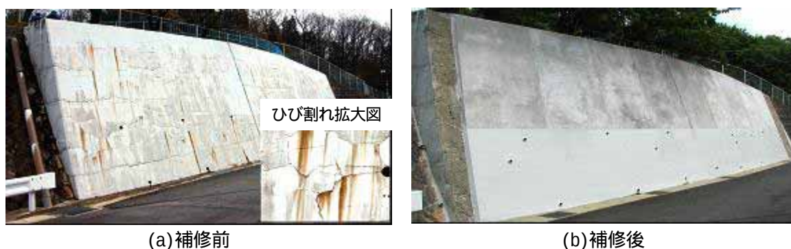
図 - 4.3 計測対象とした重力式コンクリート擁壁
