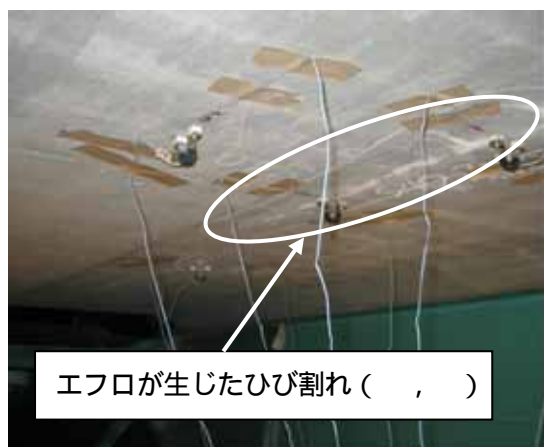
図 - 2.2 設置したパイ型変位計の様子
