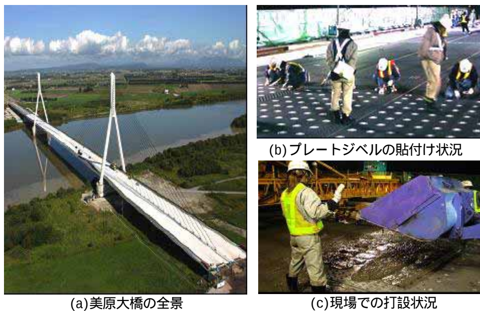
図 - 1.4 美原大橋における主橋梁部の道路床版補強
