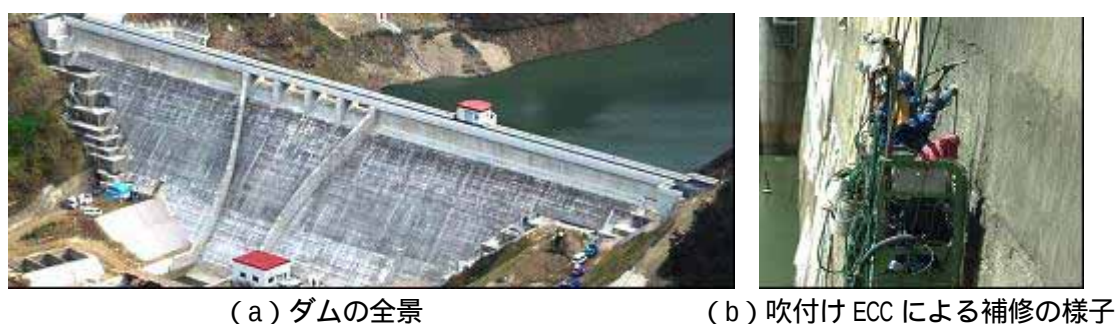
図 - 1.5 ダム堤体の補修
