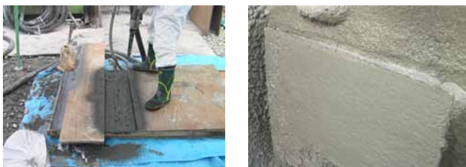
図 - 5 吹付け施工（左図：吹付け状況，右図：仕上げ状況）
