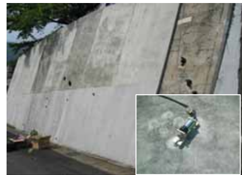
写真-2 計測対象（擁壁）と計測状況
